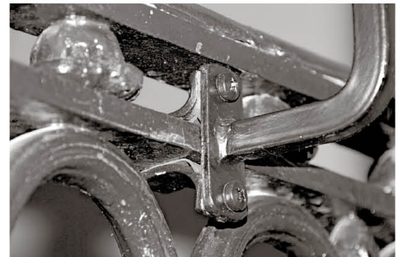
● Соединялись историческая конструкция и новелл очень аккуратно клёпками
