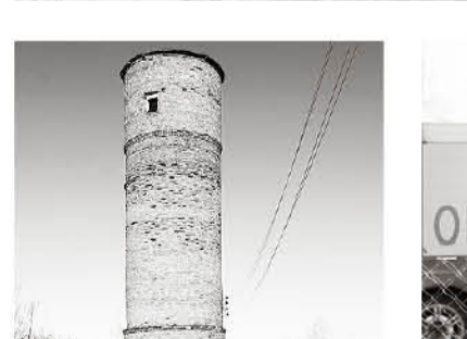
Вильская водонапорная башня построена в середине 1960-х, после чего в домах местных жителей появился долговязый центральный водопровод
