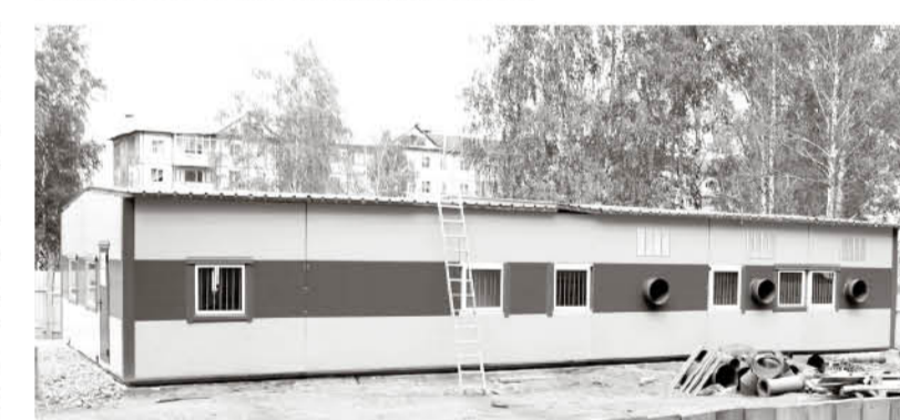
● В м-не Мотмос установили новый модуль, но его ещё надо подключить
