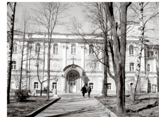
1854-1861 гг. Перестройка храма преподобного Сергия в Сергиевской Приморской пустыни. Санкт-Петербург
