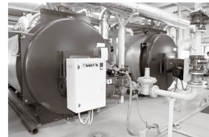
● В котельной №20 всё готово к пуску тепла
