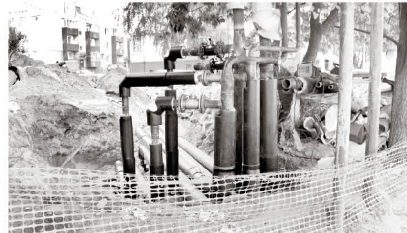
● На ул. Пушкина заменили старые трубы на новые, с полипропиленовой изоляцией
