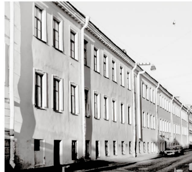
1842 г. Додолный дом. Санкт-Петербург, переулок Пирогова, д. №2, правая часть. Надстройка
