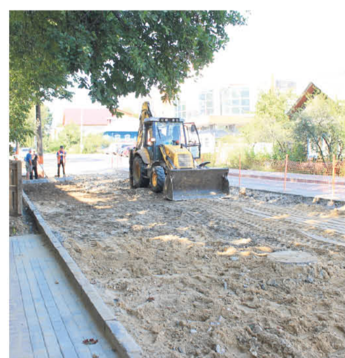
● Отремонтирована стоянка на ул. Чкалова, в районе отделения «Почты России» (2016 год)
