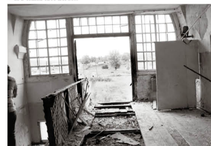
● Дубовые доски пола второго этажа довольно крепкие, потому их и воруят
