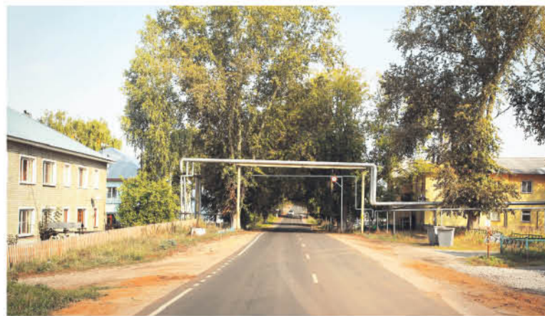
● Шиморское. Отремонтированная дорога от филиала МИСиС до завода
