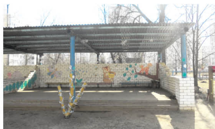
• Новенькая и красивая веранда после ремонта
