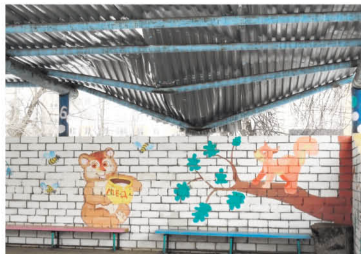
• Такой была крыша до ремонта
