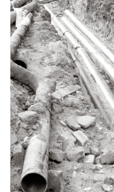
• Старые трубы подлежат замене
