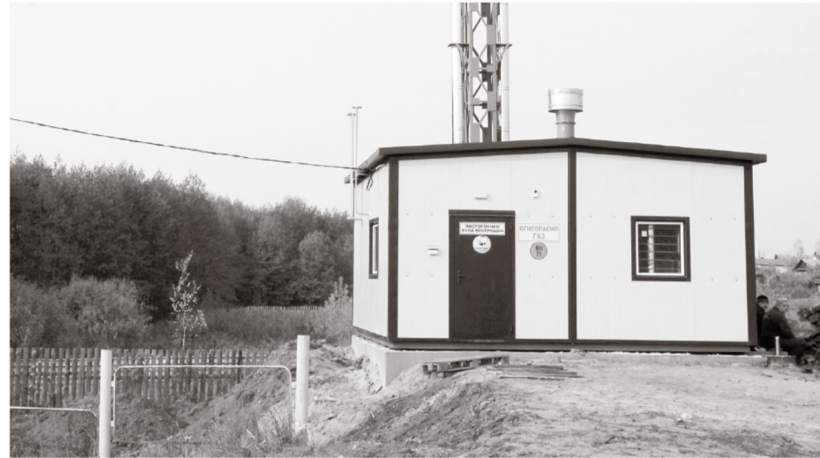
• Пять вот таких новых модульных котельных появятся в Выксе в ближайшее время благодаря инвестпроекту, реализуемому администрацией нашего округа. Эта котельная будет обеспечивать теплом школу в Мотмосе
