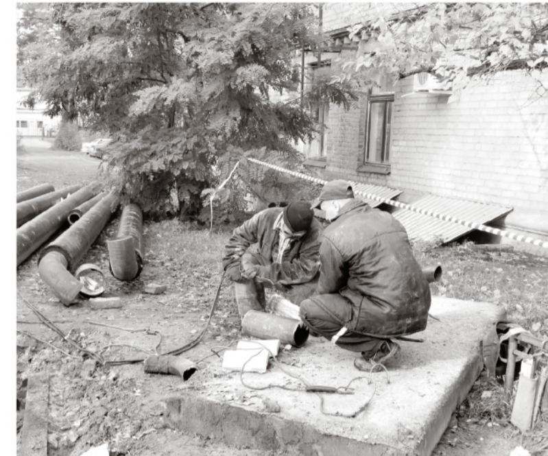
• Специалисты «Выксатеплоэнерго» обновляют магистраль
