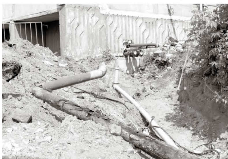
● Новые трубы проложат до вводов в многоквартиж
