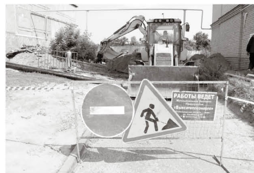
● Красная площадь. Идёт замена инженерных сетей (ГВС и отопления) между домами №14 и 16
