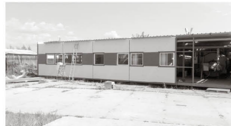
● Эту котельную установят в микрорайоне Гоголя
