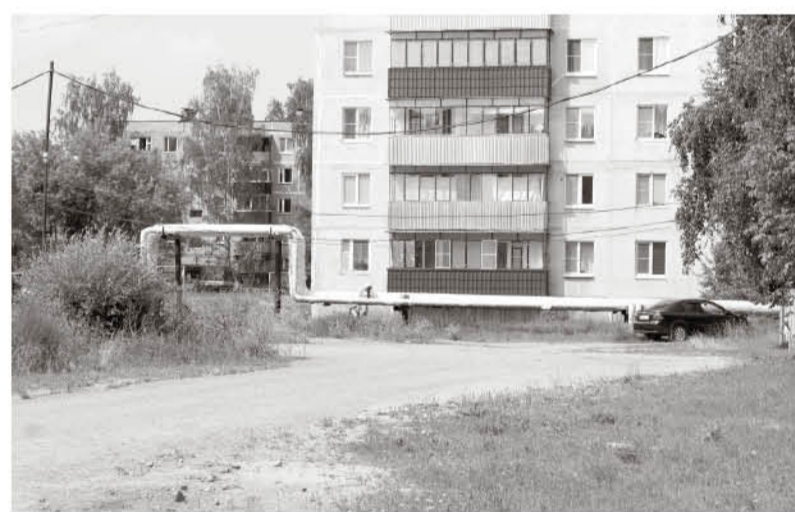
● М-оп Юбилейный. Изоляция на теплотрассе восстановлена
