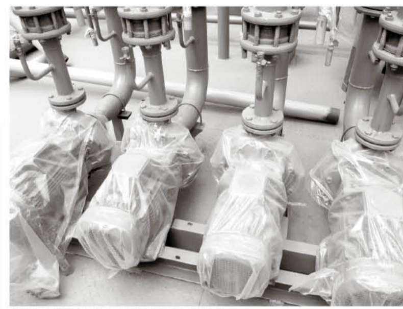
● Новое оборудование готовят к транспортировке
