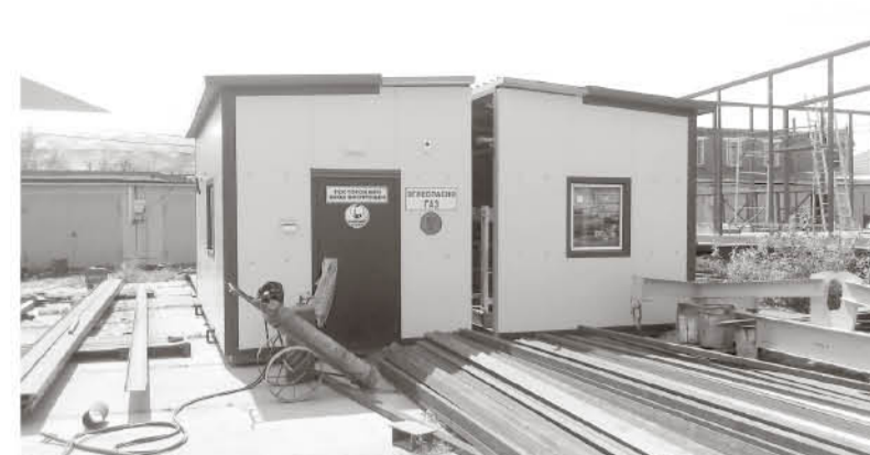
● Недавно специалисты предприятия побывали в Чебоксарах, чтобы на месте посмотреть и оценить степень готовности новых модульных котельных. По срокам исполнения к инвестору претензий нет. Теперь главное – подготовить площадку для размещения оборудования, которое уже в нынешнем году должно быть пущено в эксплуатацию.
