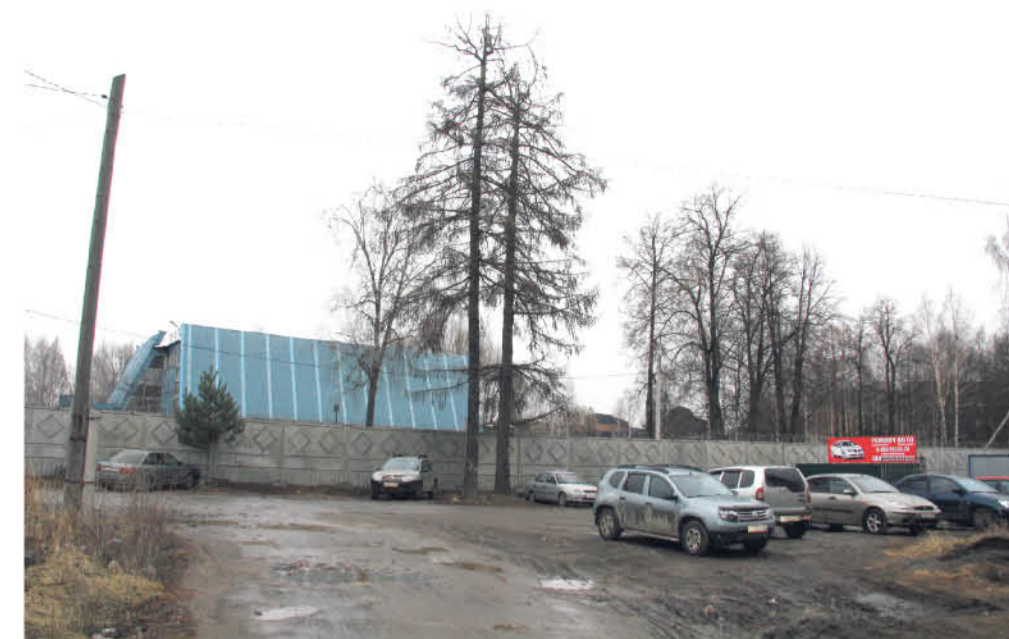
● ...и выстроен физкультурно-оздоровительный комплекс металлургического завода
