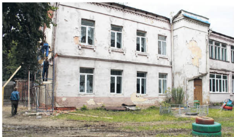
● Таким был детсад до ремонта
