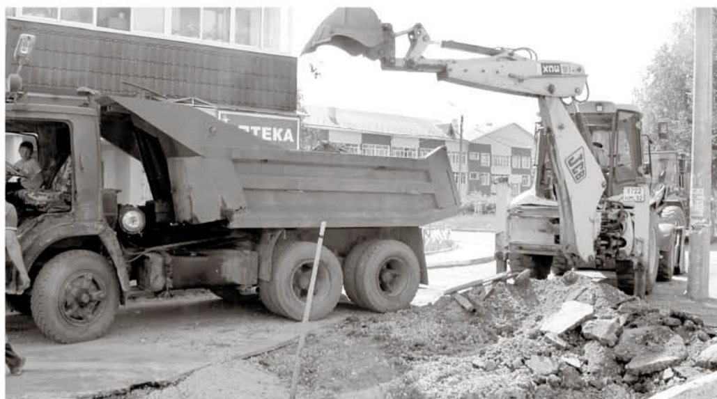
● У дома №21 в м-не Центральном работа идёт полным ходом
