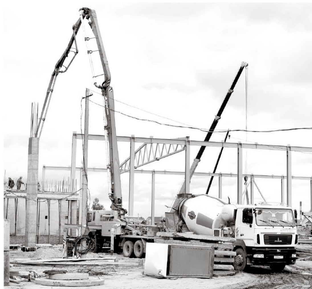
● Идёт монтаж металлоконструкций
