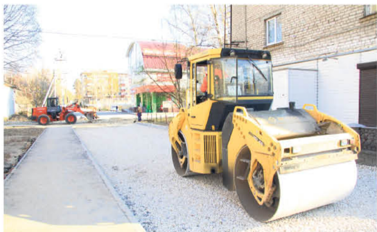
● Благоустройство дороги в м-оне Гоголя
