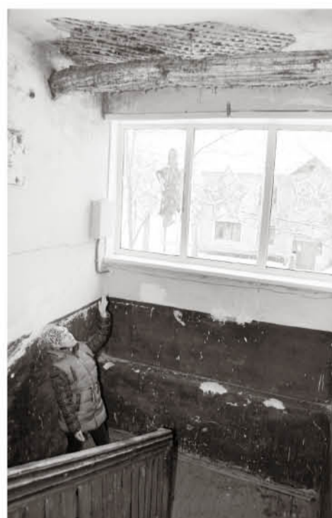
● «Звёздочки» штукатурки продолжают падать
