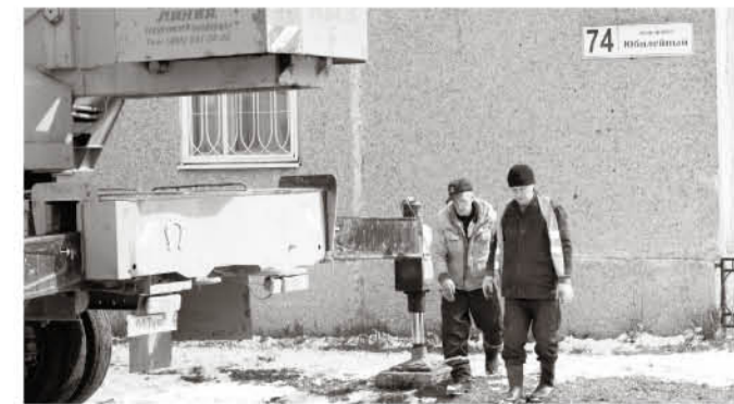
Материал для ремонта подняли на крышу краном
