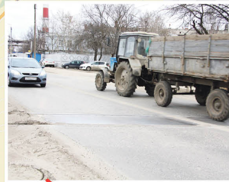
● На антоповской дороге протяженностью всего 2,3 км находится три железнодорожных переезда. Они очень сильно замедляли движение, ведь автомобилям приходилось притормаживать, проезжая через них. Сейчас эти зоны выровнены по высоте дорожного полотна. Даже автомобили с низкой посадкой легко справляются с препятствием, скорость прохождения пути увеличилась — напряженность снизилась.
