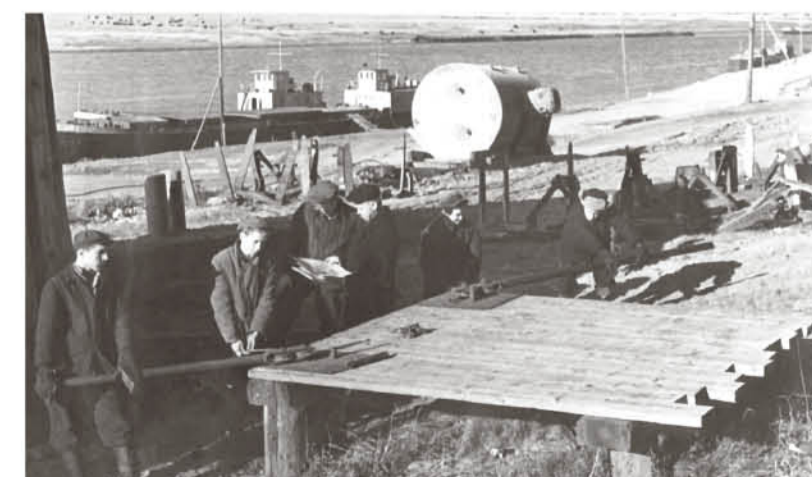
● Идёт подготовка оснастки для ремонта судна
