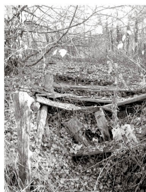
● От пожарного колодца в заброшенном посёлке осталось ныне лишь одно название: опорные столбы и ступени деревянной площадки еле держатся от ветхости, а высохшая скважина наглухо скрыта под толщей земли и прошлогодних листьев
